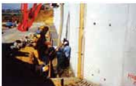
コンクリート打設完了
