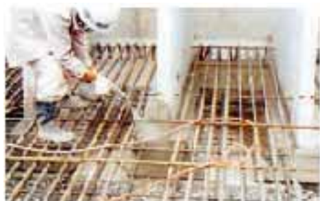
NSボンドスーパー施工
