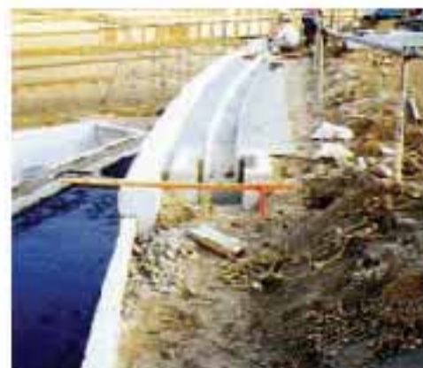
笠上げブロック施工例
